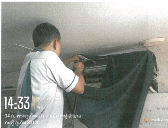
รูปภาพที่ 2.34 การทำความสะอาดเครื่องปรับอากาศ
